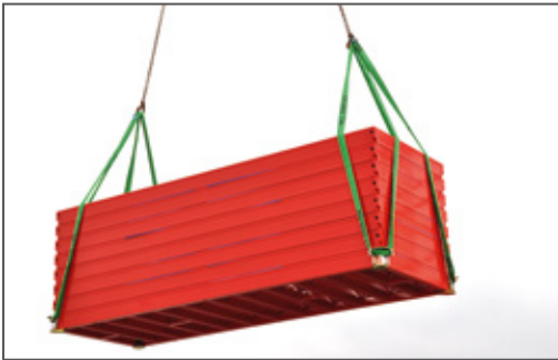
Abb. 11: Elementstapel am Kran
