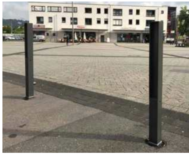
Stilpoller aus Stahlrohr 70 x 70 mm, Oberteil Flachstahl, ca. 950 mm Überflur, feuerverzinkt und beschichtet (DB 703)
