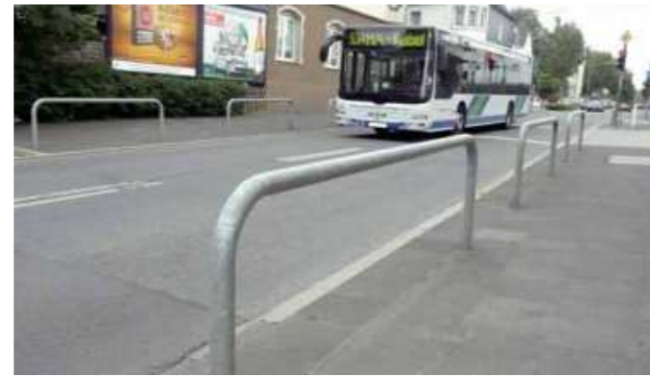
Abweisebügel Stahlrohr Ø 76 x 2,6 mm ohne Querholm
