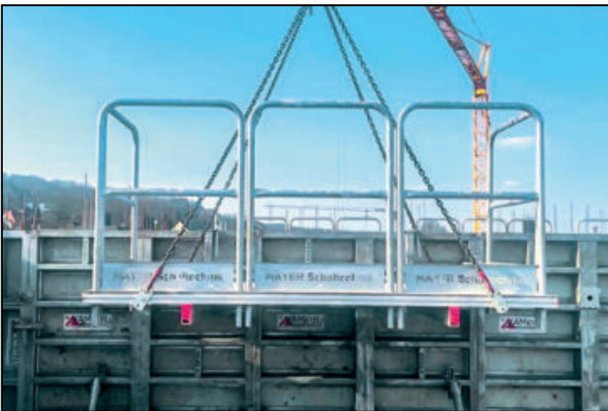
Einsatz an Rahmenschalung
