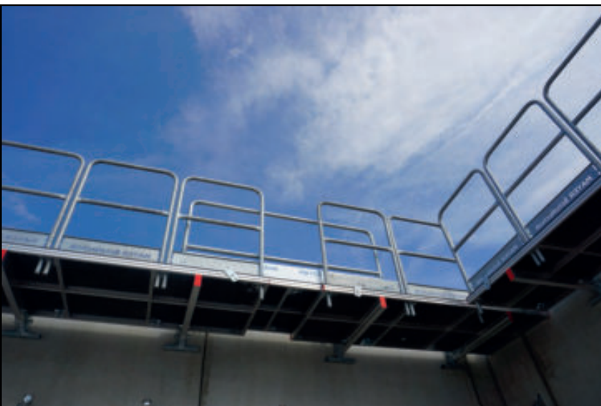
Einsatz an Hohlwand
