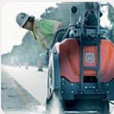
SCHNELLSTRASSEN UND LANDEBAHNEN
