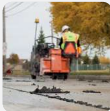
FUGEN- UND SÄGEREPARATUREN
