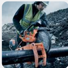
SCHNEIDEN VON ROHREN
