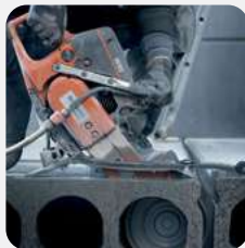
SCHNEIDEN VON FAHRBAHNDECKEN
