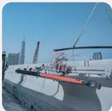
ABBRUCH VON WÄNDEN
